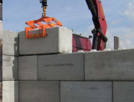
einfache Montage mit Versetzzange
